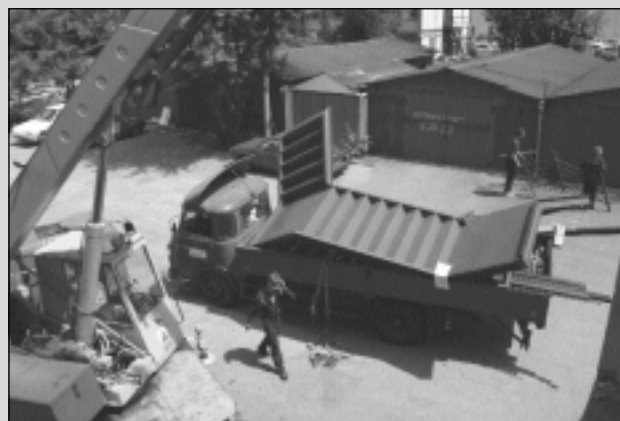
Takhle to ještě nevypadalo příliš složitě.
